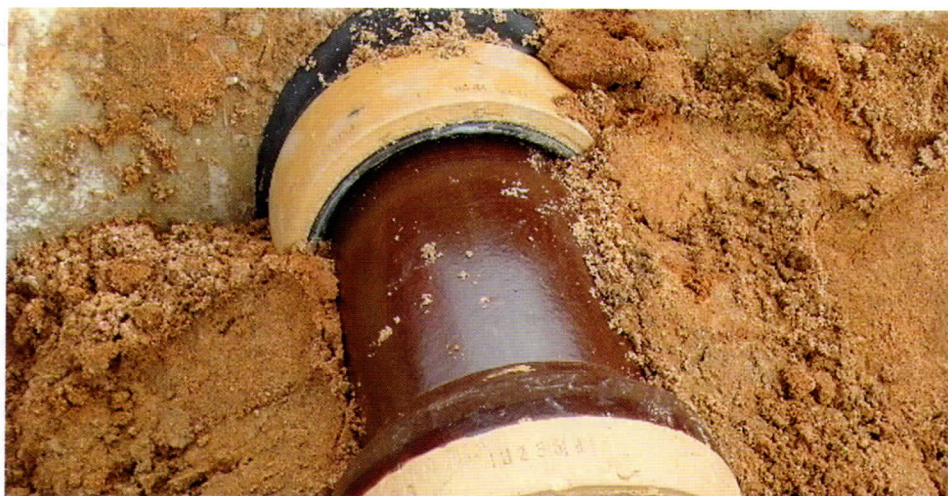
Mineralische Kapselung einer Rohrleitung mit Derneton-Fertigmischung. | Foto: Dernbach
