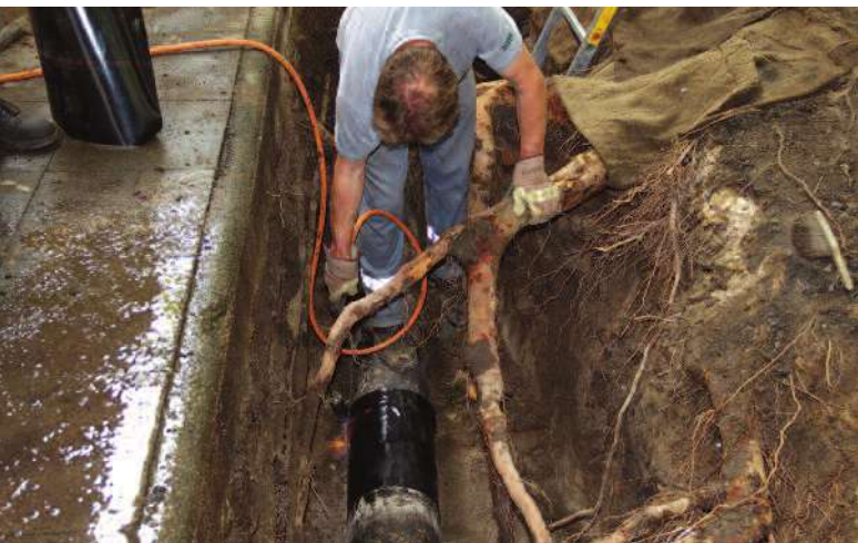
Reparaturarbeiten an geschädigter Gashochdruckleitung.
