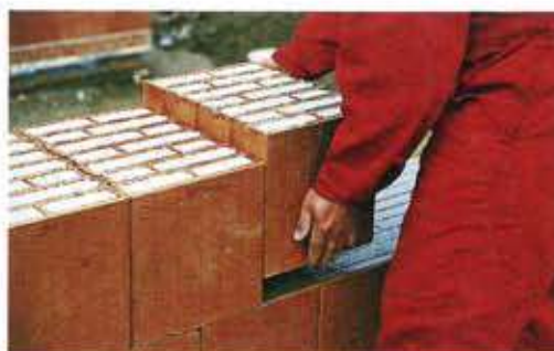
Bild 1. Leistungsträger für hochwärmedämmende Gebäudehüllen ist dieser perlitverfüllter Poroton-Ziegel
