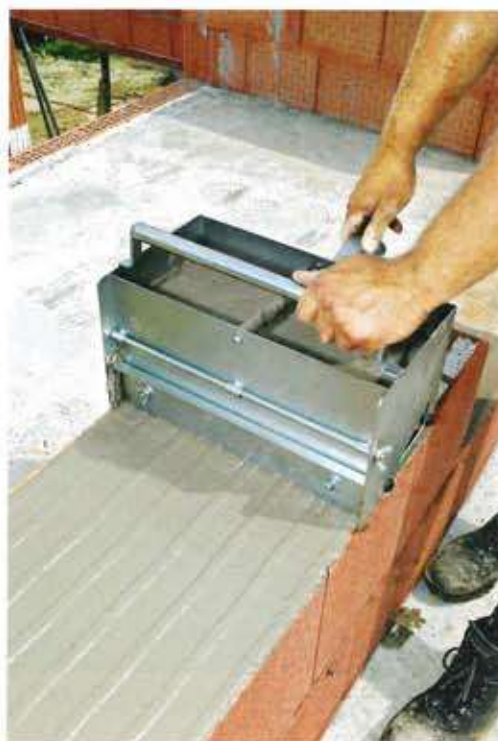
Bild 2. Eine Sequenz aus dem Film – durch das Auftragen von Dünnschichtmörtel kann äußerst wirtschaftlich gemauert und sicher verarbeitet werden
