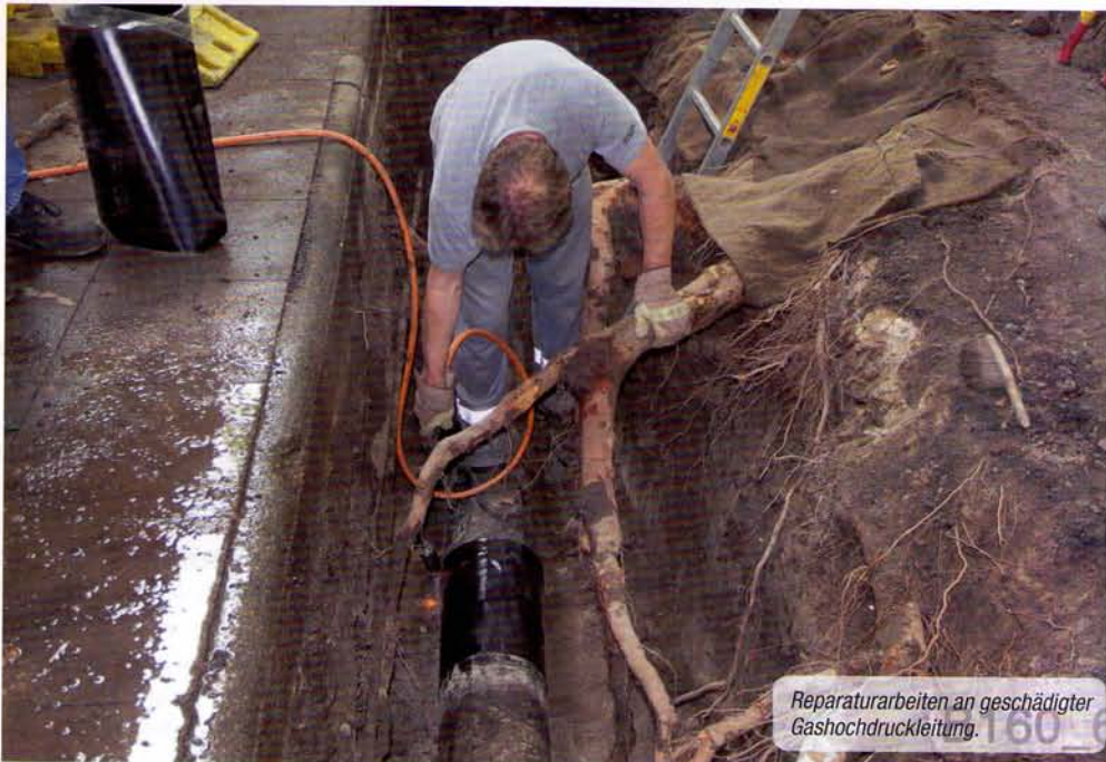
Druckstempel einer Eichenstarkwurzel auf Gasversorgungsleitung. Fotos (2): DPB-ARCHIV
