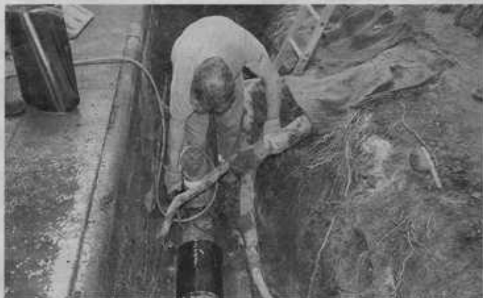
Bei der Sicherung von Leitungstrassen und Gasleitungen vertraut die Stadt Hannover auf das Ton-Sand-Gemisch Dernoton. Die Fertigmischung ist luft- und wasserdicht und verhindert das Eindringen von Wurzeln in die Leitungszone.
