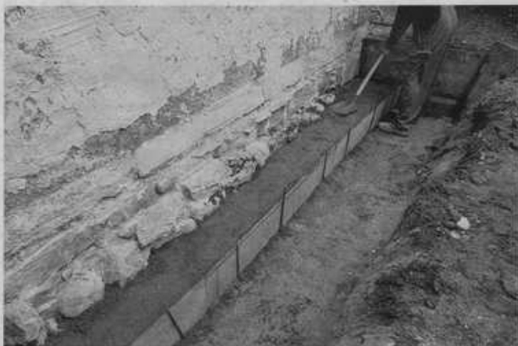
Mit Dernoton ist selbst bei sehr klüftigen Fundamenten eine unproblematische Abdichtung möglich. Zur Vorbereitung muss das Mauerwerk lediglich besenrein gesäubert werden und ein entsprechender Arbeitsraum vor dem Fundament geschaffen werden. Foto: Dernbach
