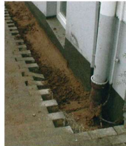
Die Tonmischung drückt sich in die Zwischenräume des Mauerwerks und füllt diese aus.
