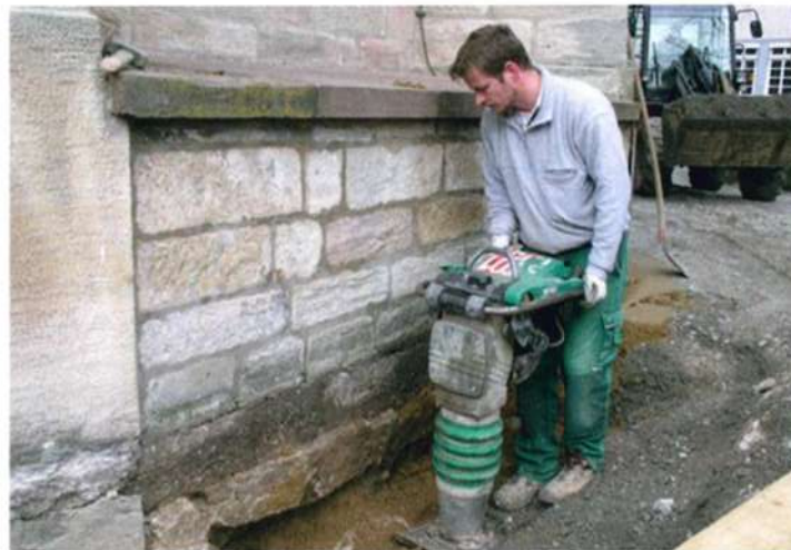
In den restlichen Arbeitsraum kommt der Aushub. Nach Entfernen des Trennstreifens wird alles mit einem Stampfer verdichtet.
