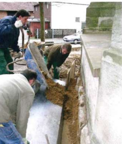
Mischung wird gleichmäßig breit zwischen Trennstreifen und Fundament eingebracht.
