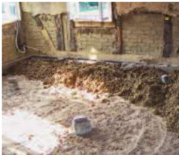
Das Einbringen des Baumaterials.
