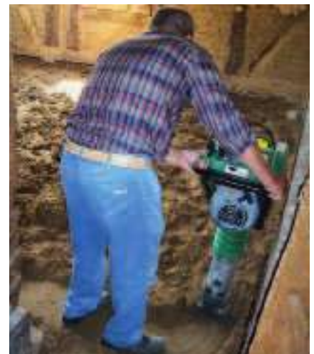
Verdichten des Materials mittels Stampfer.
