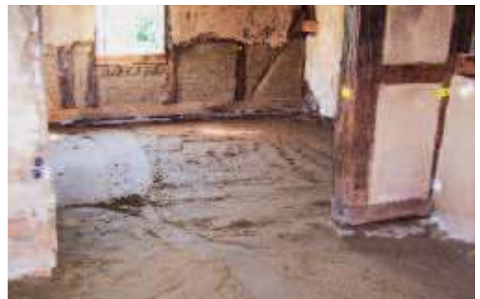
Das verdichtete Baumaterial.
