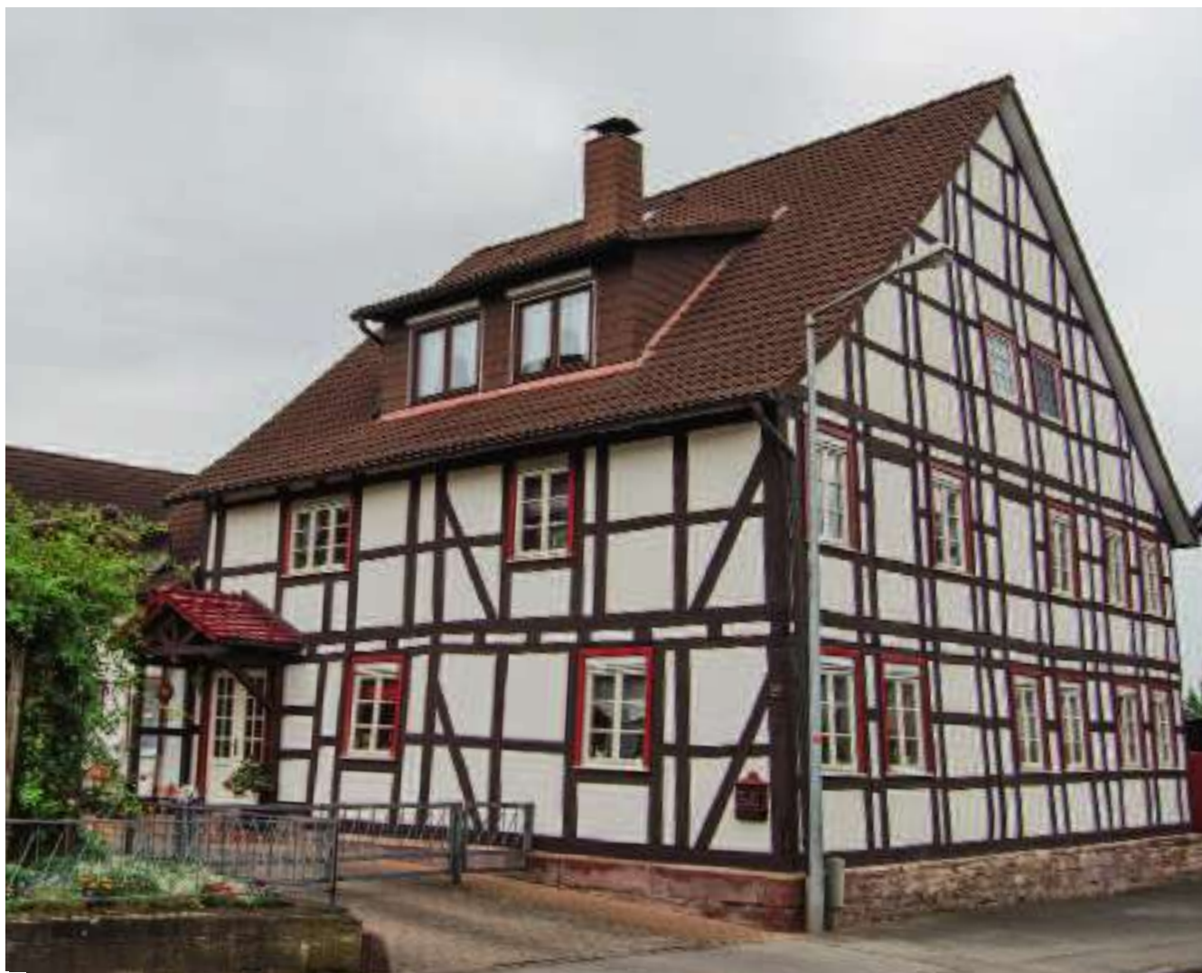
Ökologisch sinnvoll: Das Fachwerkhaus wurde ausschließlich mithilfe natürlicher Baustoffe saniert.
