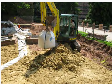
Abb.3: Einbringen der DERNOTON®-Fertigmischung BA mit Hilfe eines Baggers
