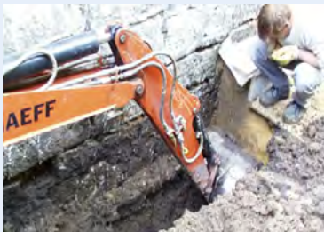
Freilegen des Fundamentes für den nächsten Bauabschnitt
