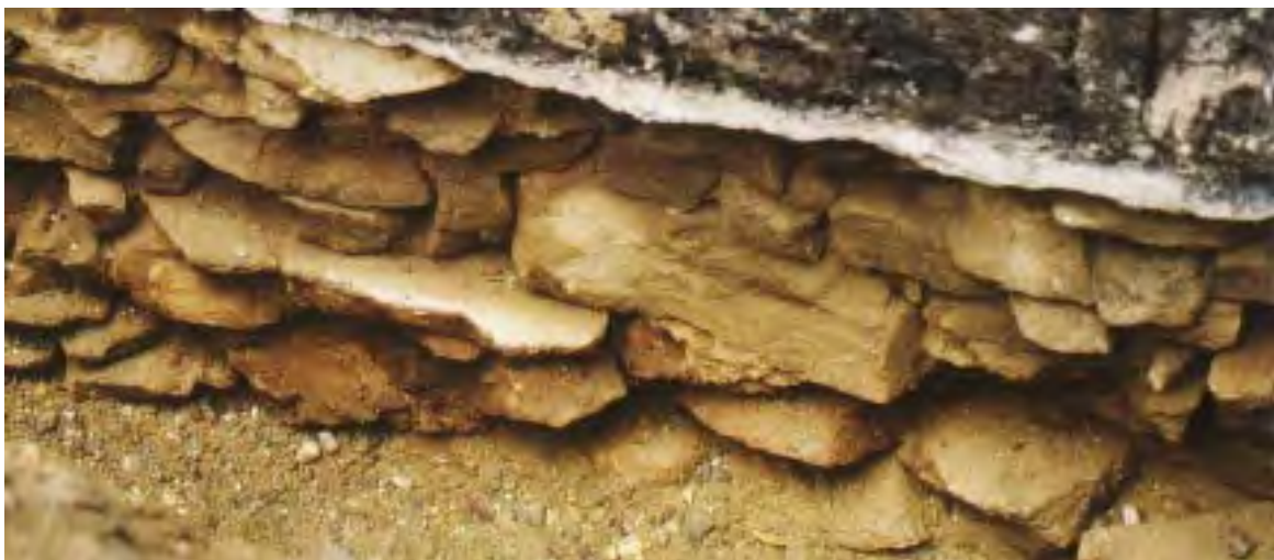
Selbst dieses klüftige Fundament konnte, ohne vorherige Bearbeitung, problemlos mit DERNOTON®-Fertigmischung BA abgedichtet werden.
