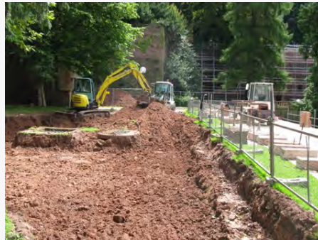
Abb.2: Herstellen des Arbeitsraumes für die horizontale Abdichtung
