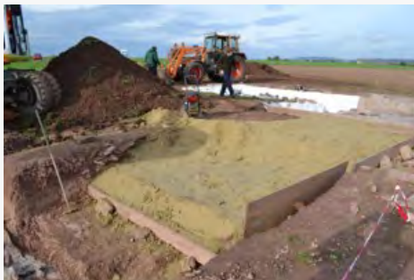
Einbau der DERNOTON®-Fertigmischung BA (Foto: P. Wolters)
