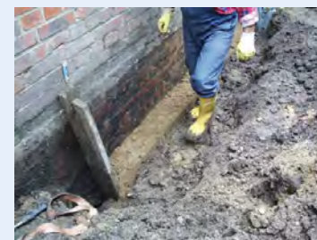
Holzbohle als Begrenzung des zu bearbeitenden Bauabschnittes
