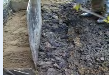
Trennstreifen während des Einfüllens
