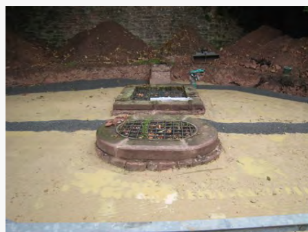
Abb.6: DERNOTON®-Fertigmischung BA eingebaut und verdichtet, es fehlt noch ein abschließender Oberflächenschutz
