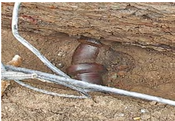
Von Hand verdichtete Rohrdurchführung
