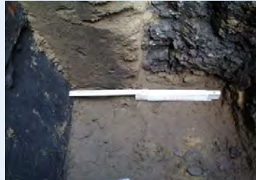
Kontrolle der Einbaustärke von 0,20 m
