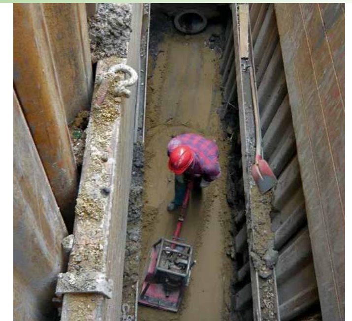
Ummantelung eines Kanalrohres mit DERNOTON ® -Fertigmischung Verdichtung der DERNOTON ® -Fertigmischung
