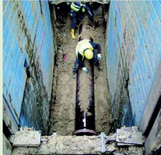
Mineralische Kapselung einwandiger Rohre mit DERNOTON ® -Fertigmischung S
