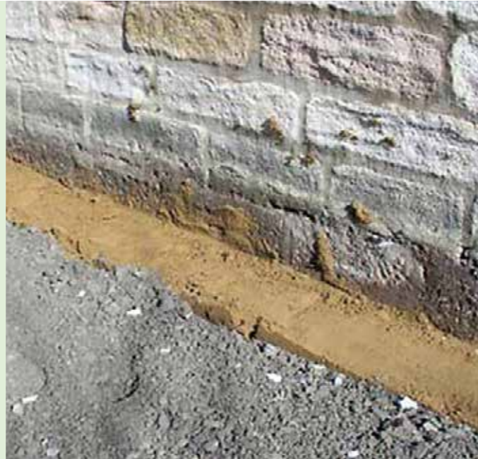
Vertikale Bauwerksabdichtung mit DERNOTON®-Fertigmischung BA Abdichtung des Innenhofes gegen in Gebäude eindringendes Oberflächenwasser
