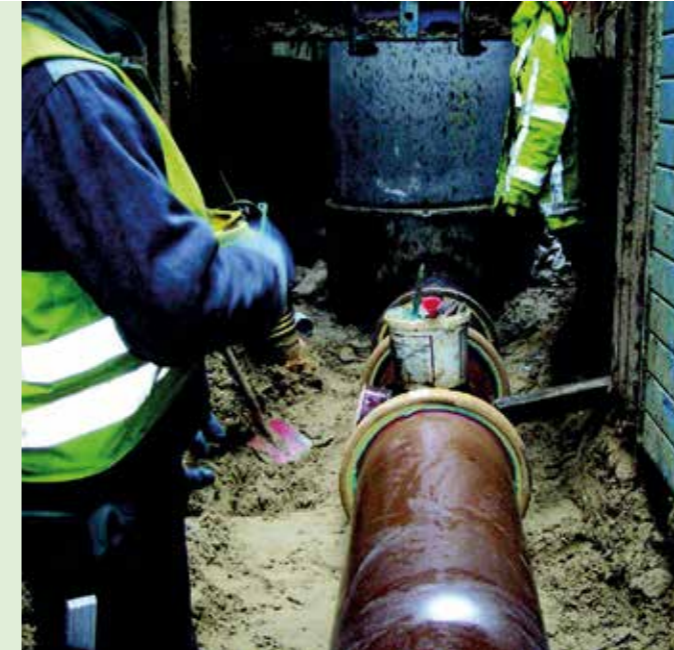
Mineralische Kapselung eines Kontrollschachtes
