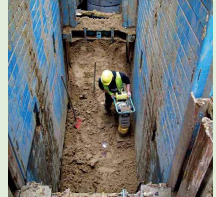
Verdichten der DERNOTON ® -Fertigmischung S bis zur geforderten Proctordichte
