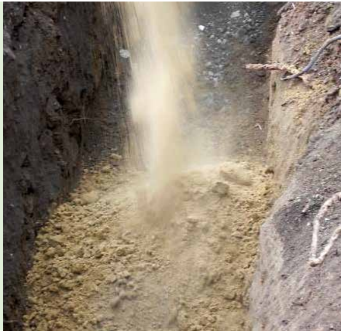
Einfüllen des wurzelfesten Materials in die Baugrube zu nachträglich zu schützenden Leitungen
