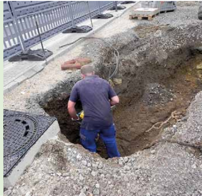
Wurzelfestes Verfüllmaterial im Bereich der Leitungszonen nach Einbau und Verdichtung
