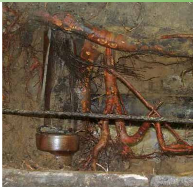
Starke Wurzelbildung unter alten Gasleitungen Hoher Wurzeldruck durch Über- und Unterwanderung führt zu Rohrleitungsschäden
