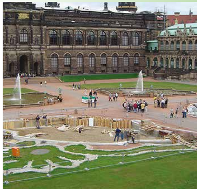
Fundamentabdichtung an einem Kirchengebäude Brunnenabdichtungsarbeiten nach Hochwasser im Dresdner Zwinger
