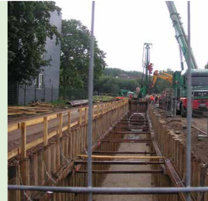
Neuverlegung eines Kanalrohres im Spundwandverbau Ummantelung eines Kanalrohres mit DERNOTON ®
