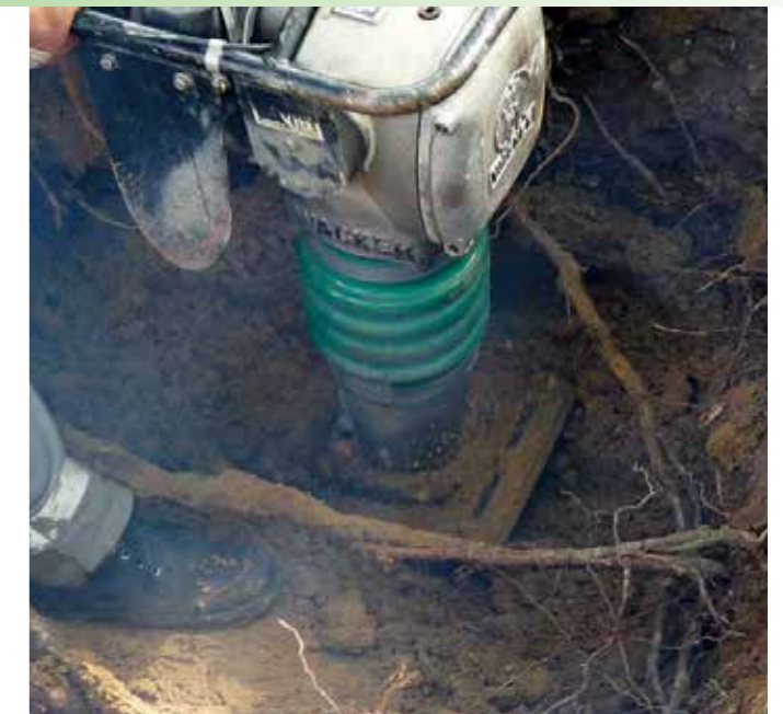
Freigelegte Rohrleitung und Baumwurzeln zwecks Auffüllung mit DERNOTON ® DERNOTON ® -Fertigmischung wird im Wurzel- und Rohrleitungsraum verdichtet
