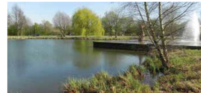
Regenrückhaltebecken im Gewerbegebiet
