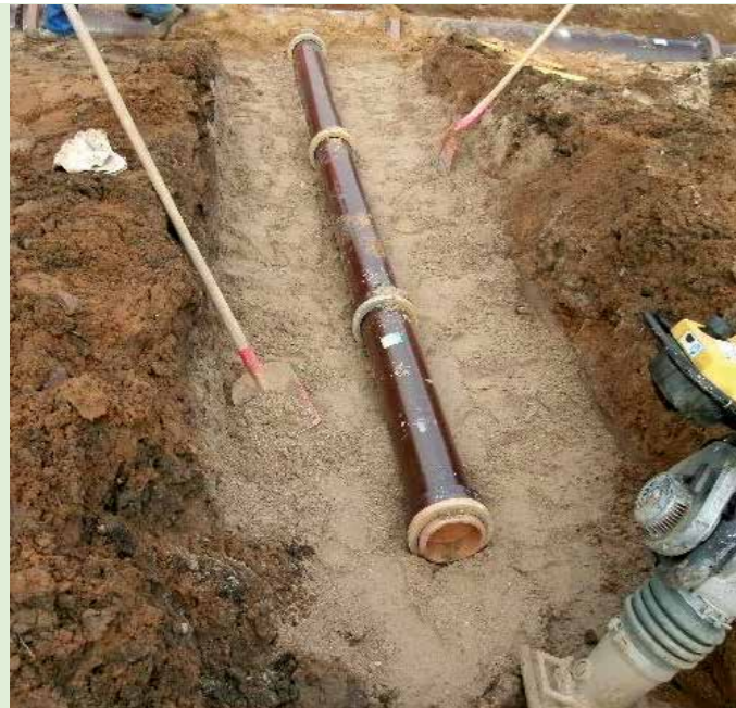
Mindestschichtdicke des Ummantelungsquerschnittes um den Rohrschaft bei \phi < \text{DN } 200 = 25 \text{ cm} , bei \phi > \text{DN } 200 bis \phi < \text{DN } 600 = 30 \text{ cm}
