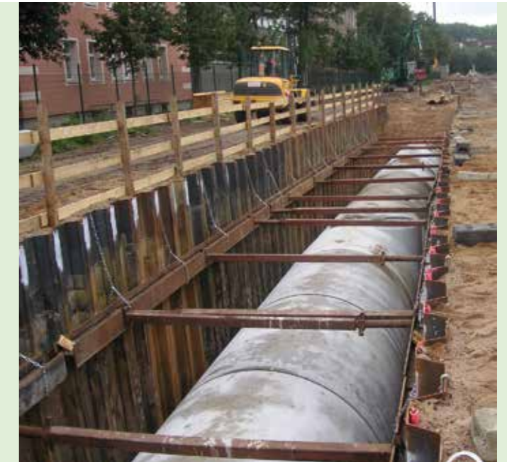
Ummantelung eines Kanalrohres mit DERNOTON ® -Fertigmischung Verdichtung der DERNOTON ® -Fertigmischung
