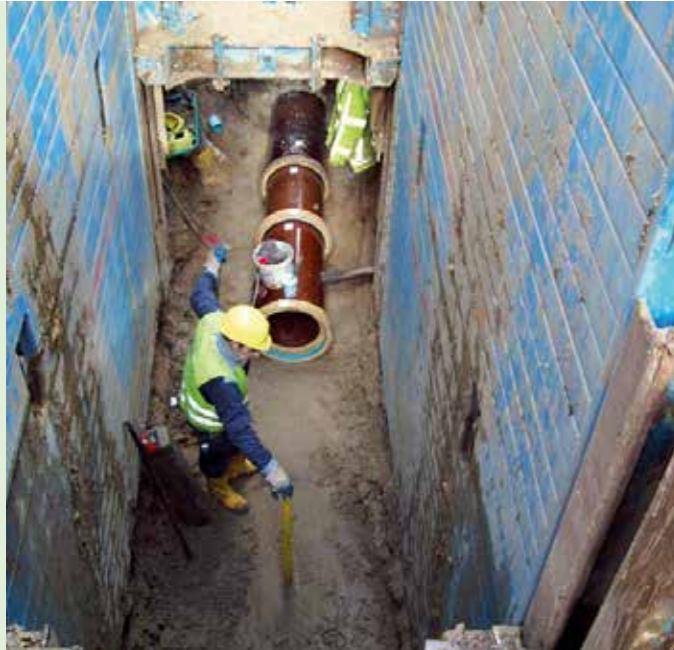
Einbau der DERNOTON ® -Fertigmischung S auf der verdichteten Baugrubensohle Verbau des Leitungsgrabens im innerstädtischen Bereich
