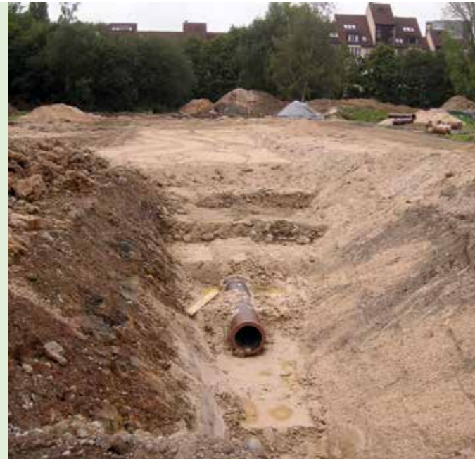
Abdichtung einer Verrohrung mit DERNOTON ® im offenen Verbau
