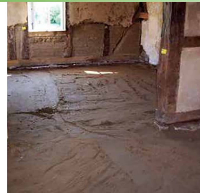
Bauwerksabdichtung bei einem denkmalgeschützten Wohnhaus mit DERNOTON®-Fertigmischung BA zur horizontalen Abdichtung im Gebäudeinnenbereich
