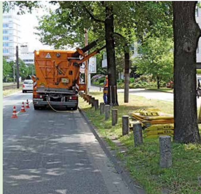
Saugbagger zum Freilegen der Rohrtrasse Zugwurzeln können zu gravierenden Rohrleitungsschäden führen
