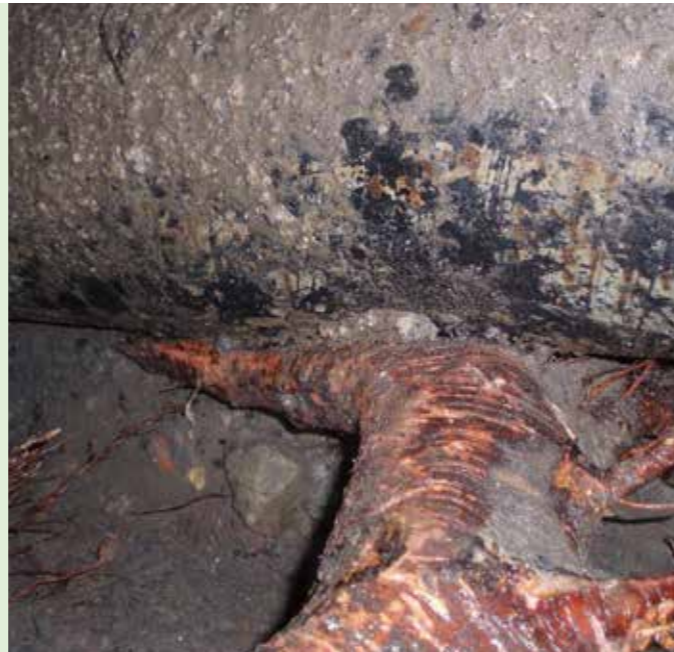
Starke Wurzelbildung unter alten Gasleitungen Hoher Wurzeldruck durch Über- und Unterwanderung führt zu Rohrleitungsschäden
