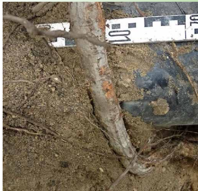
Saugbagger zum Freilegen der Rohrtrasse Zugwurzeln können zu gravierenden Rohrleitungsschäden führen
