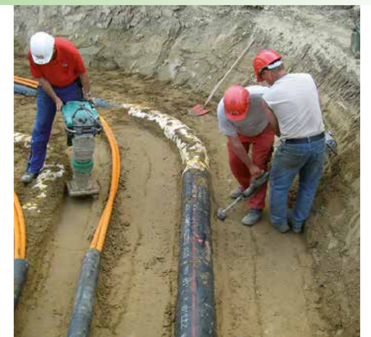
Abdichtung von Gasleitungen bei der Rhein-Deichquerung mit DERNOTON ® -Fertigmischung
