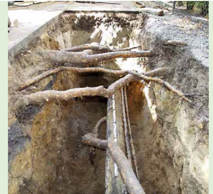
Freigelegte Rohrleitung und Baumwurzeln zwecks Auffüllung mit DERNOTON ® DERNOTON ® -Fertigmischung wird im Wurzel- und Rohrleitungsraum verdichtet
