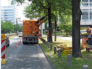
Saugbagger zum Freilegen der Rohrtrasse; Gutachter kontrolliert den Wurzeleinwuchs in die Rohrtrasse
