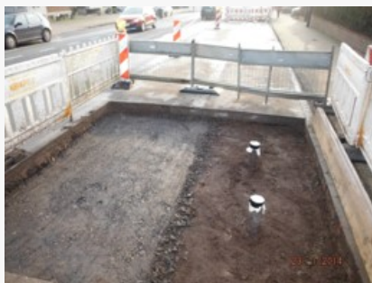
... und nach dem Einfüllen des Baumsubstrates
