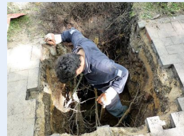
Rohrtrasse nach fachmännischer Entfernung der Wurzeln, vor Verfüllen der DERNOTON ® -Fertigmischung S
