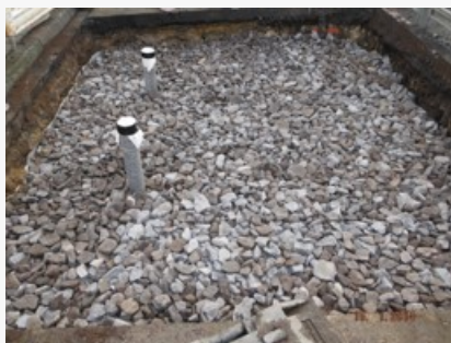
Pflanzbeet nach dem Einfüllen der Eifellava ...
