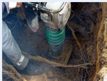
Schutz der Gasleitungen vor weiterem Wurzeleinwuchs durch den fachgerechten Einbau der DERNOTON ® -Fertigmischung S
