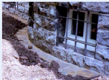
Oberflächenschutz aus Natursteinen
