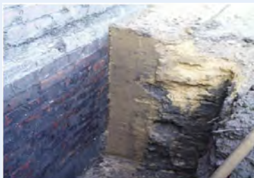
Fertiger Bauabschnitt, Holzbohle entfernt
