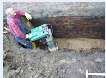
DERNOTON®-Fertigmischung BA und Füllboden werden gleichzeitig verdichtet
