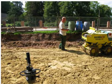
Abb.4: Verdichten der DERNOTON®-Fertigmischung BA (mind. 97% Proctordichte)
