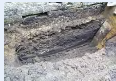
Holzbohle zum Schutz des fertigen Bauabschnittes
