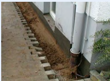
Oberflächenschutz aus Pflastersteinen darunter DERNOTON®-Fertigmischung
