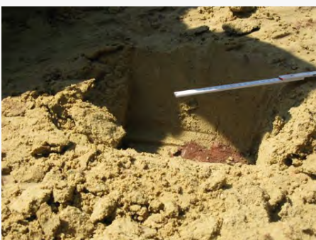
Abb.5: Überprüfen der Schichtstärke (ca. 0,2m)
