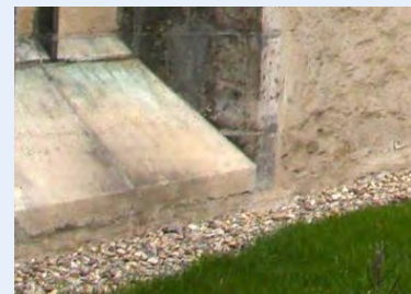
Oberflächenschutz aus Kies
