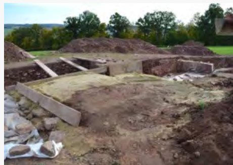
Nach Einbau und Verdichten der DERNOTON®-Fertigmischung BA (Foto: P. Wolters)
