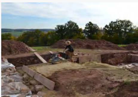
Verdichten der DERNOTON®-Fertigmischung BA (Foto: P. Wolters)
