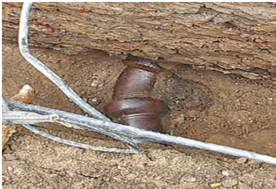
Von Hand verdichtete Rohrdurchführung
