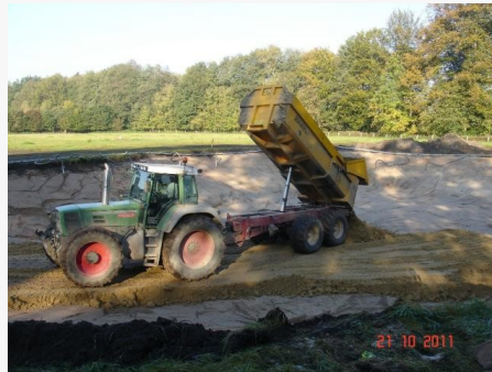
Einbau der Abdichtung
