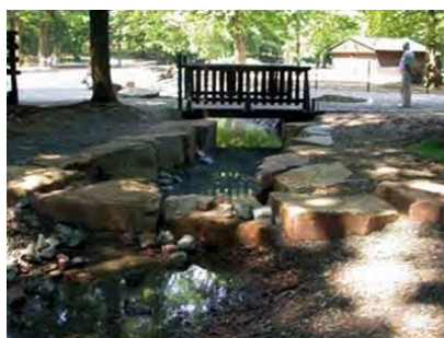
Schutzschicht aus großen Einzelsteinen. Die Hohlräume wurden mit kleinen Bruchstücken aufgefüllt, um ein Ausspülen der DERNOTON®-Fertigmischung zu verhindern.
