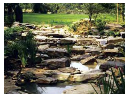
Schutzschicht aus großen Einzelsteinen. Die Hohlräume wurden mit kleinen Bruchstücken aufgefüllt, um ein Ausspülen der DERNOTON®-Fertigmischung zu verhindern.
