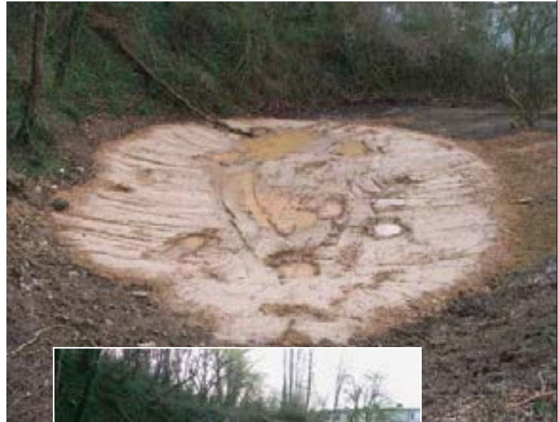
Abb. 6: Zustand 2011 vor der Maßnahme.
