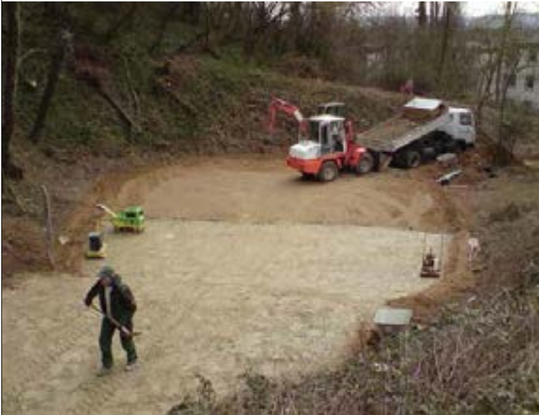
Abb. 9: 10.03.2011: Einbringen der 10 cm dicken Abdeckschicht.
