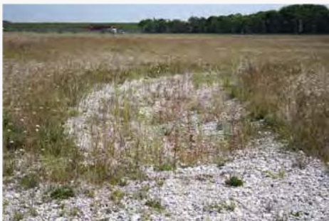
Abdichtung mit herkömmlichem „Deponieton“ ca. ein Jahr nach Fertigstellung: undicht
