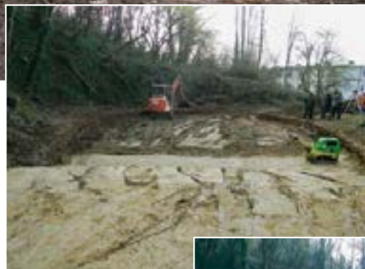
Abb. 7: 01.03.2011: Einbringen des Dichtmaterials (Dernoton) auf die verdichtete Kies-schicht.
