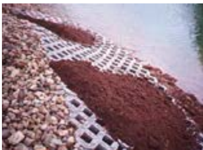
Hier wurden z. B. Rasengittersteine verwendet.
