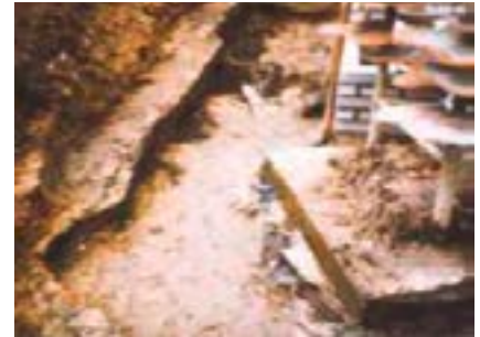
Untergrund und Ränder der alten Abdichtungsschicht aus DERNOTON®-Fertigmischung wurden zur Reparatur vorbereitet.
