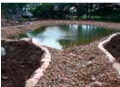
Schutzschicht aus Kies.
