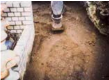
DERNOTON®-Fertigmischung verdichten.
