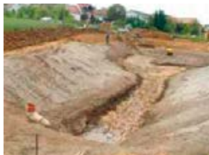
Einbau der DERNOTON®-Fertigmischung, Sohle wurde nachgedichtet.
