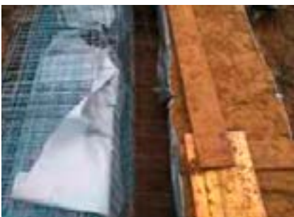
Verfüllen der Gabionen mit Aushub.
