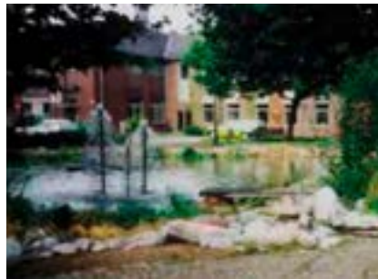
Teichanlage nach Reparatur der alten Abdichtungsschicht aus DERNOTON®-Fertigmischung.
