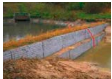
Naturnahe Randgestaltung der alten Betonbecken.
