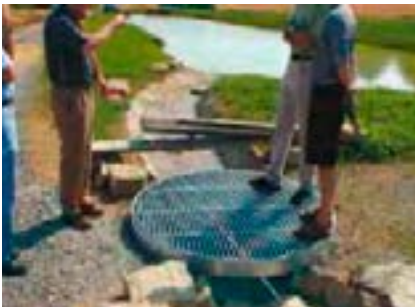
Rost als Brücke, darunter Schlammfang.
