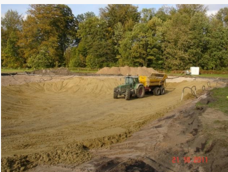
... ist sofort befahrbar
