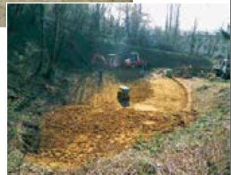
Abb. 8: 04.03.2011: Nahezu fertige Abdichtung.
