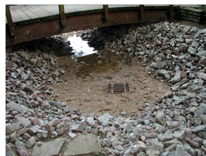
Hier wurden z. B. Wasserbausteine verwendet.
