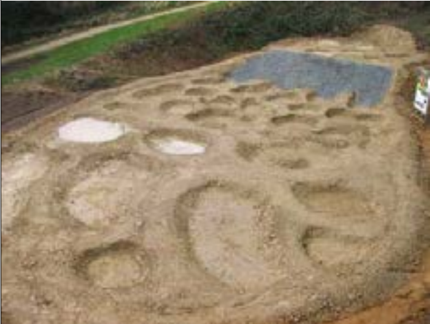
Abb. 11: 15.03.2011: Befestigte Böschung und Testbefüllung einzelner Gewässer.
