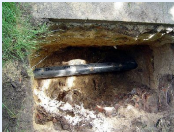
Rohrtrasse nach fachmännischer Entfernung der Wurzeln, vor Verfüllen der DERNOTON ® -Fertigmischung S
