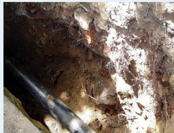
Rohrtrasse nach fachmännischer Entfernung der Wurzeln, vor Verfüllen der DERNOTON ® -Fertigmischung S
