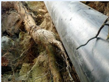
Freigelegte Rohrtrasse, gut erkennbar die starke Wurzelbildung, auch unter den Gasleitungen
