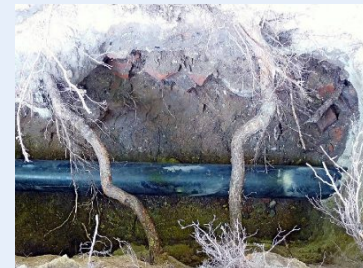
Freigelegte Rohrtrasse, gut erkennbar die starke Wurzelbildung, auch unter den Gasleitungen
