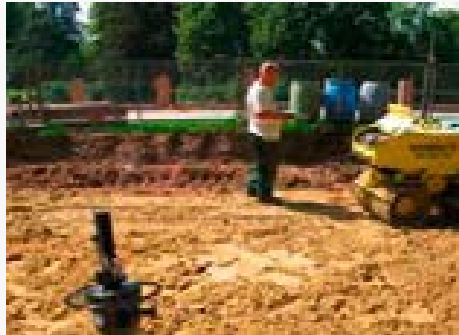
Abb.4: Verdichten der DERNOTON®-Fertigmischung BA (mind. 97% Proctordichte)
