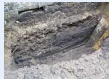
Holzbohle zum Schutz des fertigen Bauabschnittes
