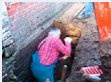
Vorbereiten eines neuen Bauabschnittes
