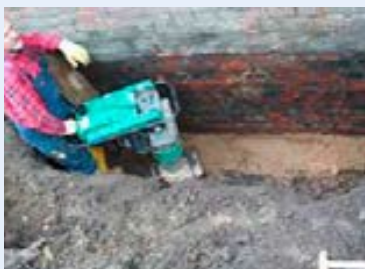
DERNOTON®-Fertigmischung BA und Füllboden werden gleichzeitig verdichtet
