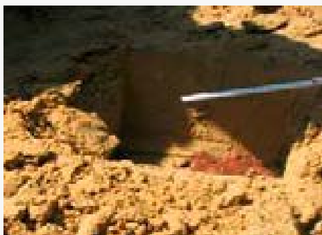
Abb.5: Überprüfen der Schichtstärke (ca. 0,2m)
