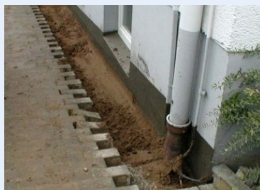
Oberflächenschutz aus Pflastersteinen darunter DERNOTON ® -Fertigmischung
