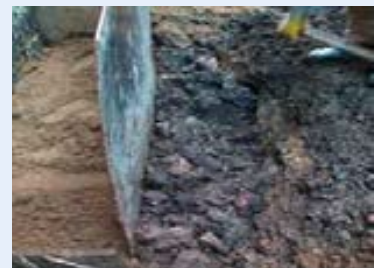
Trennstreifen während des Einfüllens
