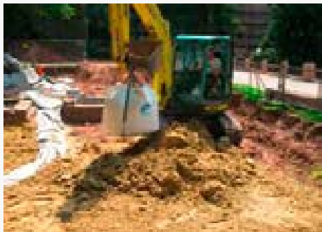
Abb.3: Einbringen der DERNOTON®-Fertigmischung BA mit Hilfe eines Baggers
