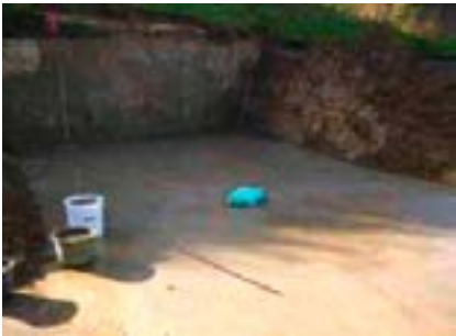
Betonrand und -boden müssen zuerst gesäubert werden.
