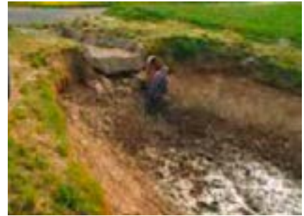
Grundverschmutzung und mangelhafte Dichtung.
