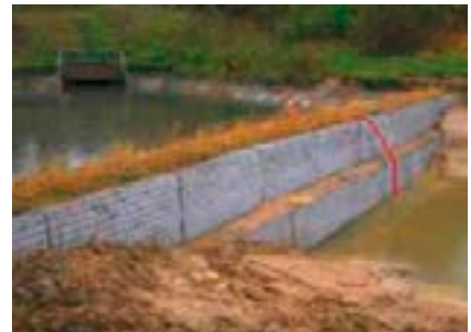
Naturnahe Randgestaltung der alten Betonbecken.
