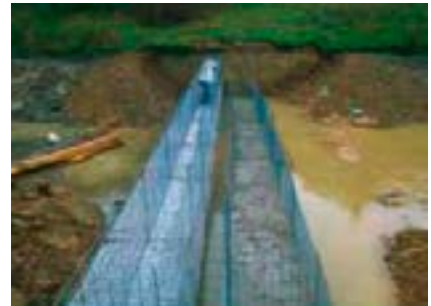
Aufstellen von zwei Reihen Gabionen.
