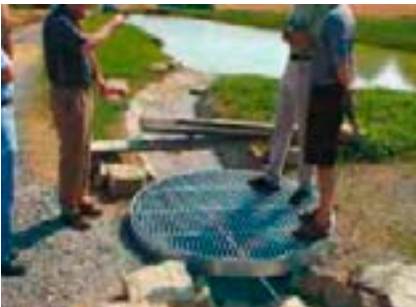
Rost als Brücke, darunter Schlammfang.
