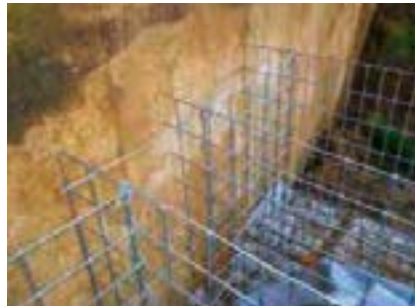
Anschluss der Gabionen an die Betonwand.
